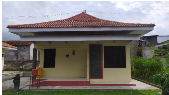
Gambar 3. Tampak Depan Bangunan Perhotelan Terpadu Sumber: (Data Tim, 2021)
