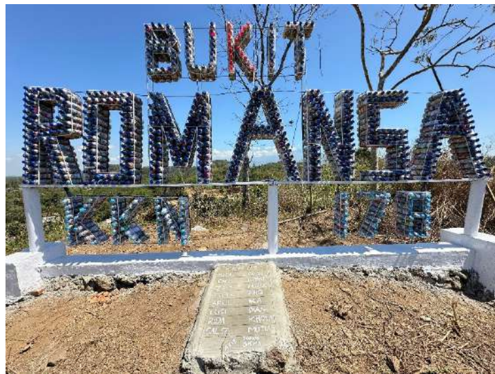
Gambar 6. Hasil pemasangan ecobrick pada kerangka nama Bukit Romansa
